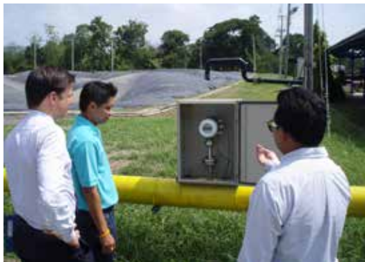
Biogasanläggningen utanför Vientiane i Laos. Under gummidukarna bryts det organiska materialet ned.
