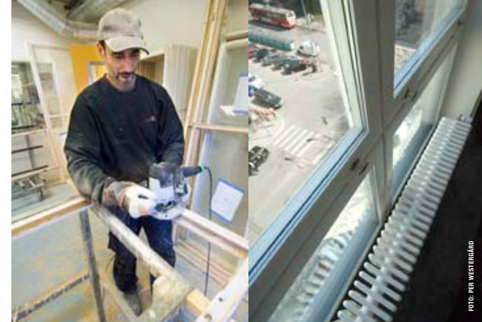
Tumba Glas är ett av företagen som satsat på uppgradering av gamla fönster. På bilden: Sinan Dewod.
