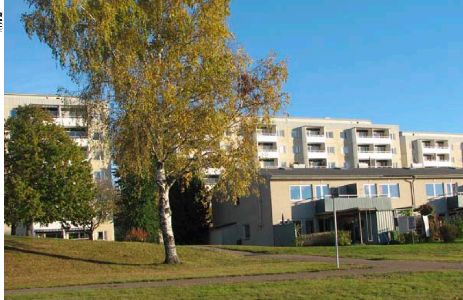
Bättre isolering och treglasfönster är några av åtgärderna i bostadsområdet Orrholmen i Karlstad.
