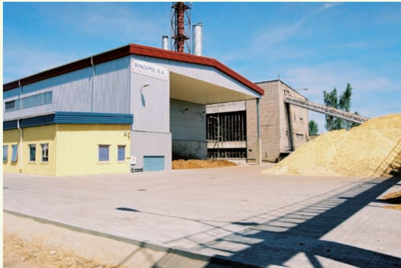
Polens enda biobränsleeldade värmeverk, i Chojnice, konverterades av det svenska företaget Rindi Energi. Bränslepannan har en toppeffekt på 20 MW.
