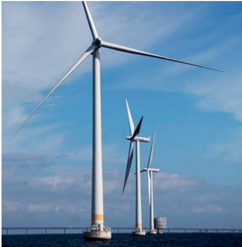
Lillgrund mellan Malmö och Köpenhamn är en av Sveriges största vindkraftsparker.
