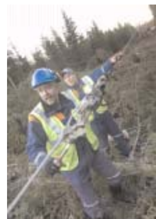
Personal och materiel från hela Europa togs in i arbetet efter stormens efterdyningar. Sydkraft tvingas nu bygga upp cirka 330 mil ledning från grunden
