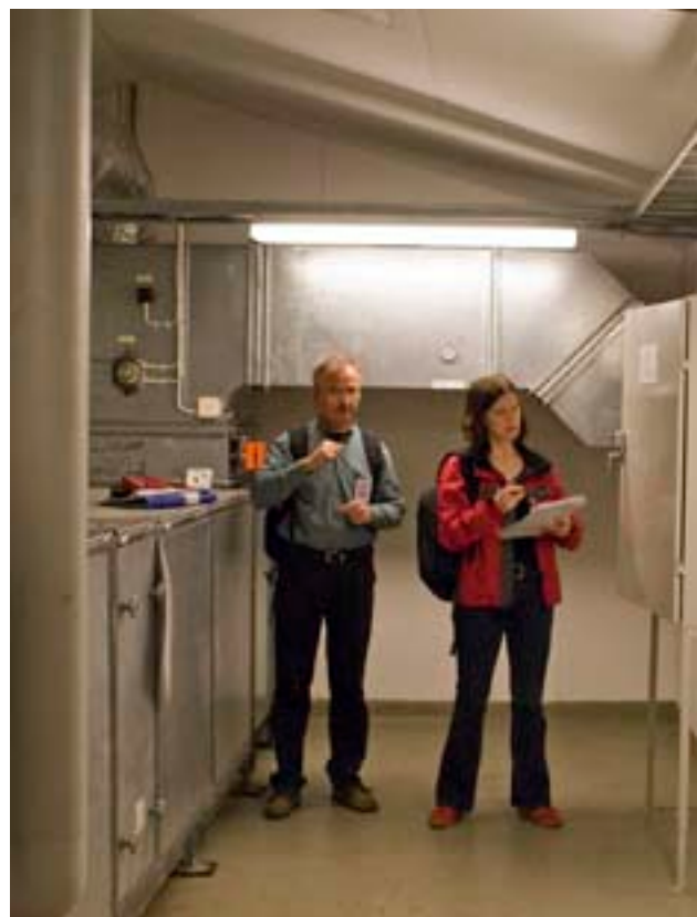
Björn Sjöholm och hans kollega Åsa Robin mäter effekten på fläktarna i ventilationssystemet.
