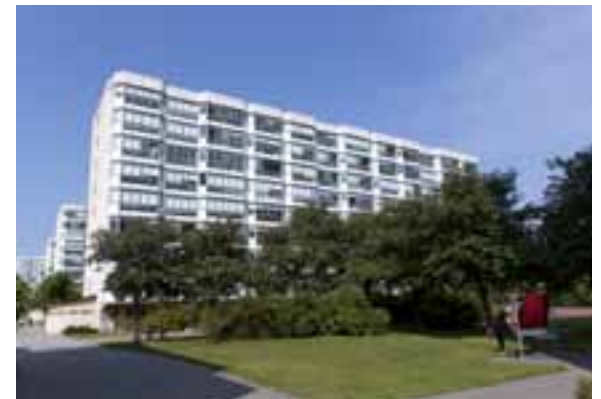
Fasaderna i området har omfogats och innerväggarna har isolerats.
