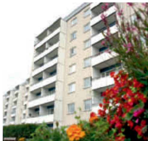
Väggarna tilläggsisolerades och energieffektiva fönster ersatte de gamla.
