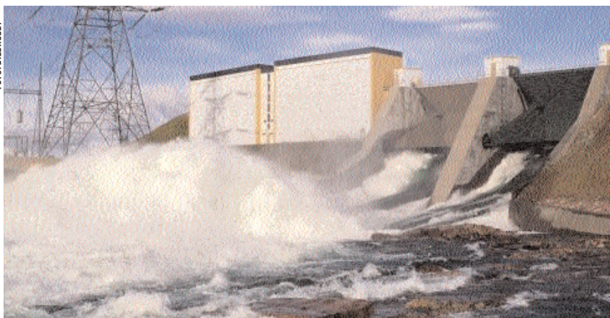
Vattenkraftverk som har en effekt på över 10 MW ska beläggas med extra avgifter i Energimyndighetens förslag. På bilden: Porjus kraftverk i Stora Luleälven.
