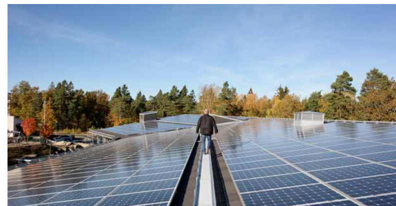
Lars Friskopp inspekterar solcellspanelerna samt växelriktarna (ovan t v) som omvandlar soledens likström till växelström. Övan t h: Dosa som mäter temperatur och koldioxidhalt – och därefter reglerar ventilationen.
