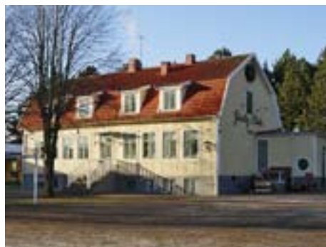
Belysningen svarar för en tredjedel av elanvändningen i Gårdby skola.
