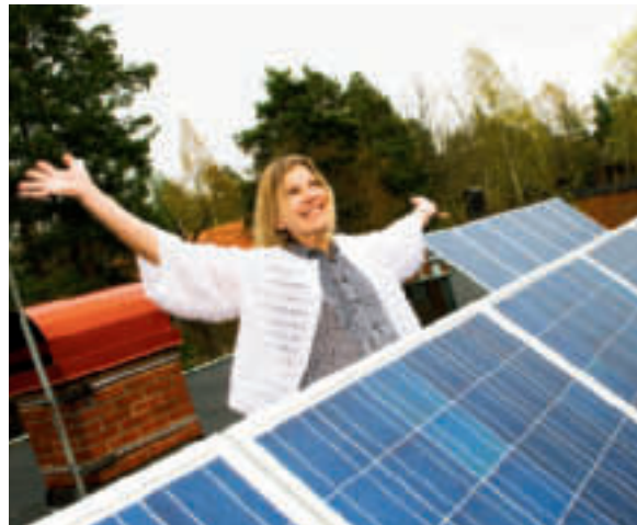
Det tog bara två dagar att få upp panelerna på taket.
