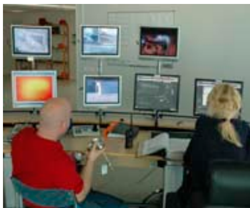
I kontrollrummet på Gärstadverken övervakas processerna i de tre avfallspannorna.
