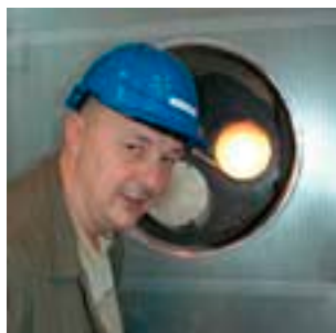
Projektledaren Mile Elez kollar värmepannan.
