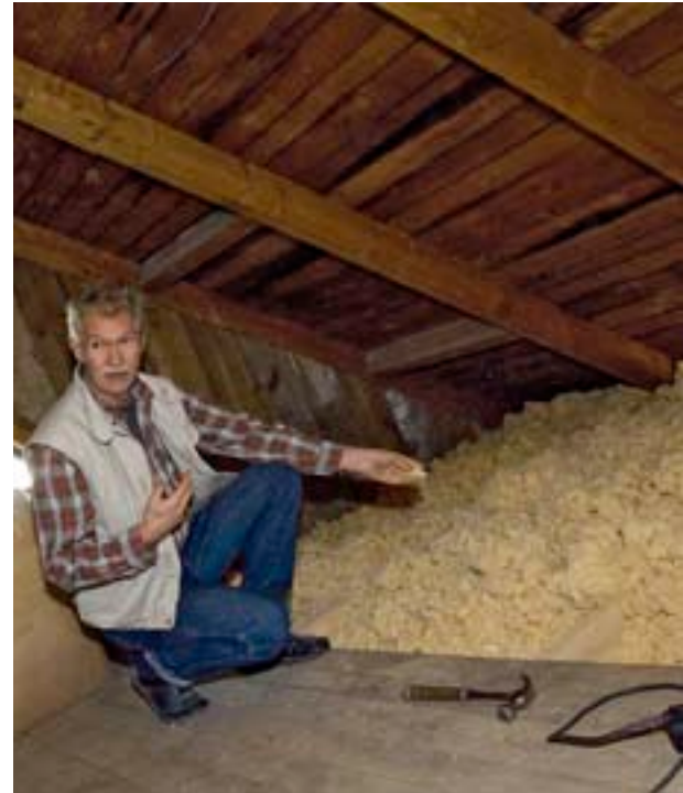
I de flesta rum finns en kakelugn. Anders Linered visar vindsisoleringen i huset, en 35 centimeter tjock ”spånmossa”.
