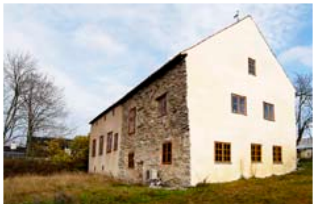
Gården Klints på Gotland är klassad som byggnadsminne. Huvudbyggnadens ursprungsdelen är från 1700-talet. Fuktskador i tak och på väggar skvallrar om att byggnaden tagit stryk av att stå ouppvärmad. Tor Broström arbetar med att försöka hitta en bra balans mellan energieffektiv uppvärmning och bevarande av kulturbyggnader.
