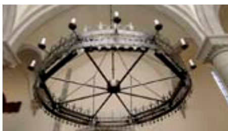
Åtta infravärmeelement i ljuskronan värmer kyrkobesökarna i Lau.
