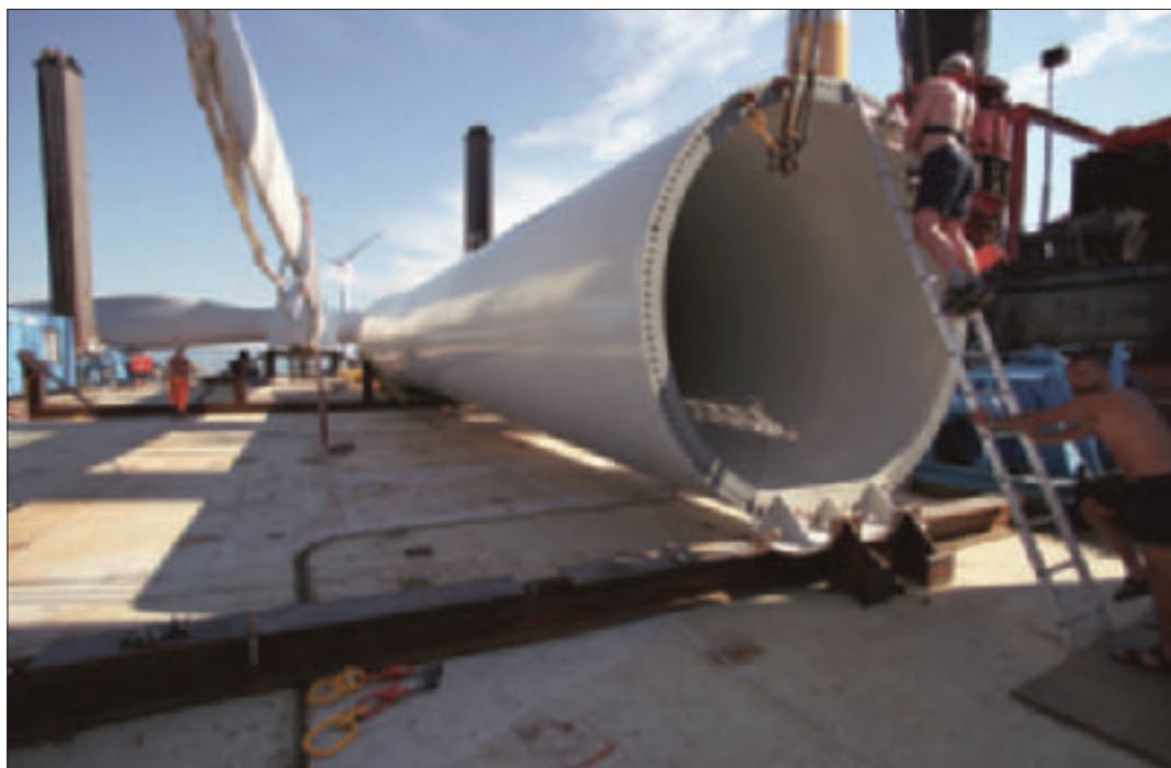
Utbyggnaden av vindkraft till havs befinner sig ännu i sin linda, men förutsättningarna bedöms vara gynnsamma om rätt teknik används. Här ska ett av fem verk om 2 MW upp vid Yttre Stengrund i Kalmarsund. Foto: Gunnar Britse.
