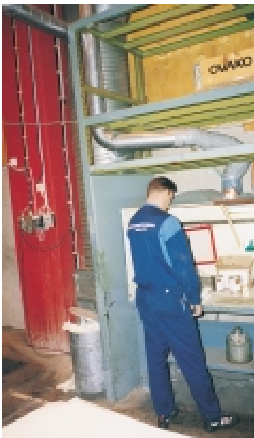
Box för blandning av epoxy. Genom att ha ett mindre, separat utsug för blandningsboxen behövde inte hela avdelningens utsug vara igång dygnet runt. Foto: ABB
