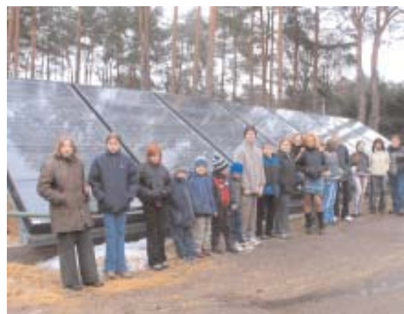
Solfångarna värmer varmvattnet i sjukhemmet under hela sommarhalvåret.
