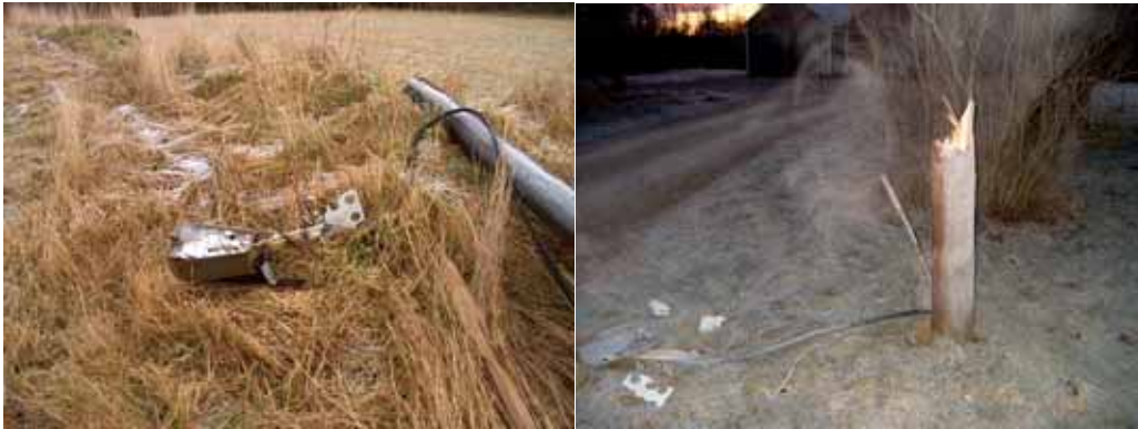
Stormskador, foto: Växjö kommun
