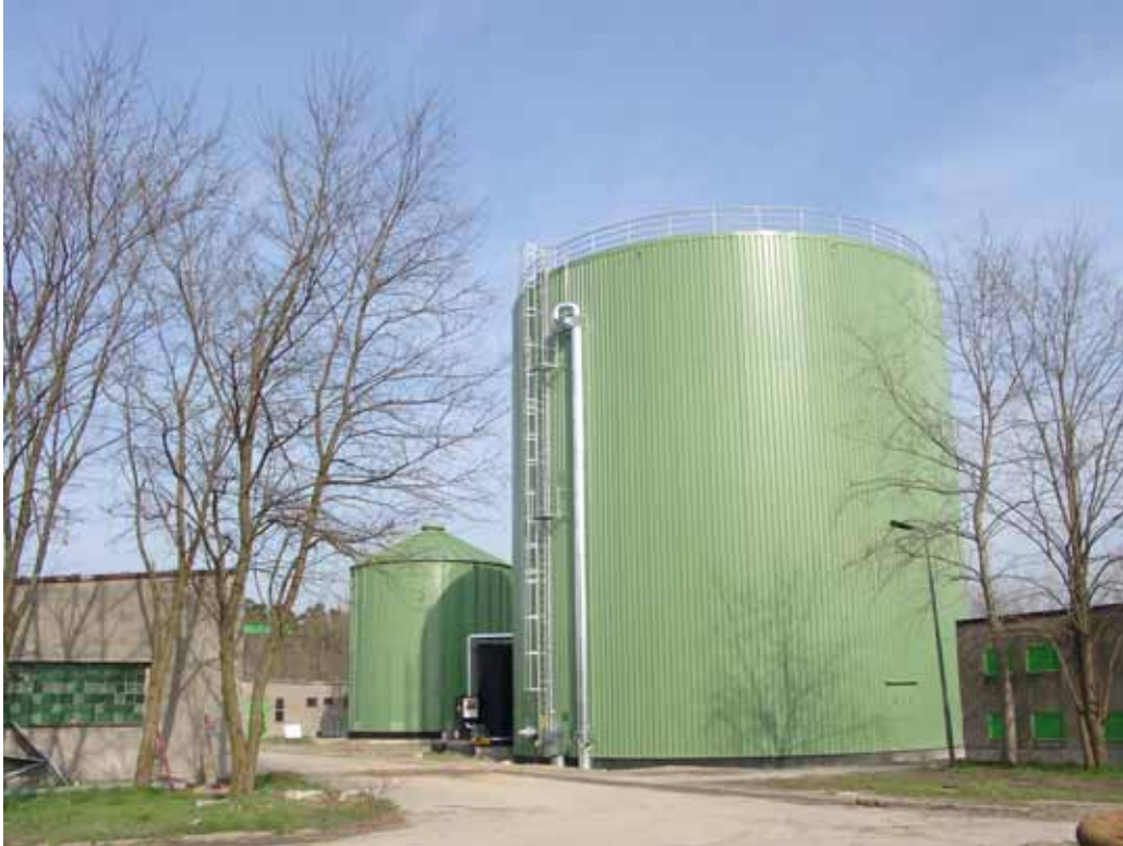
Bild 1. Rötkammaren är biogasanläggningens hjärta och består vanligtvis av en cylindrisk behållare av stål eller betong. Rötkammaren är isolerad och försedd med en omrörare för att kunna åstadkomma goda förhållanden för biogasproduktionen. Bildkälla: www.biogas.org
