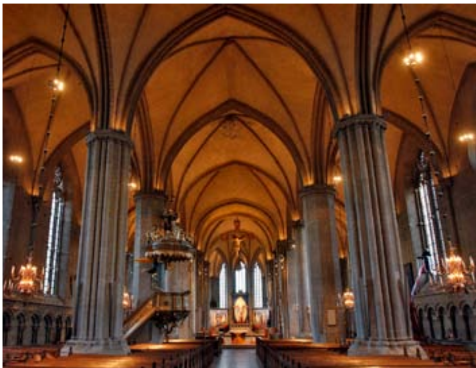
I Linköpings domkyrka fjärrstyrts värmen.
