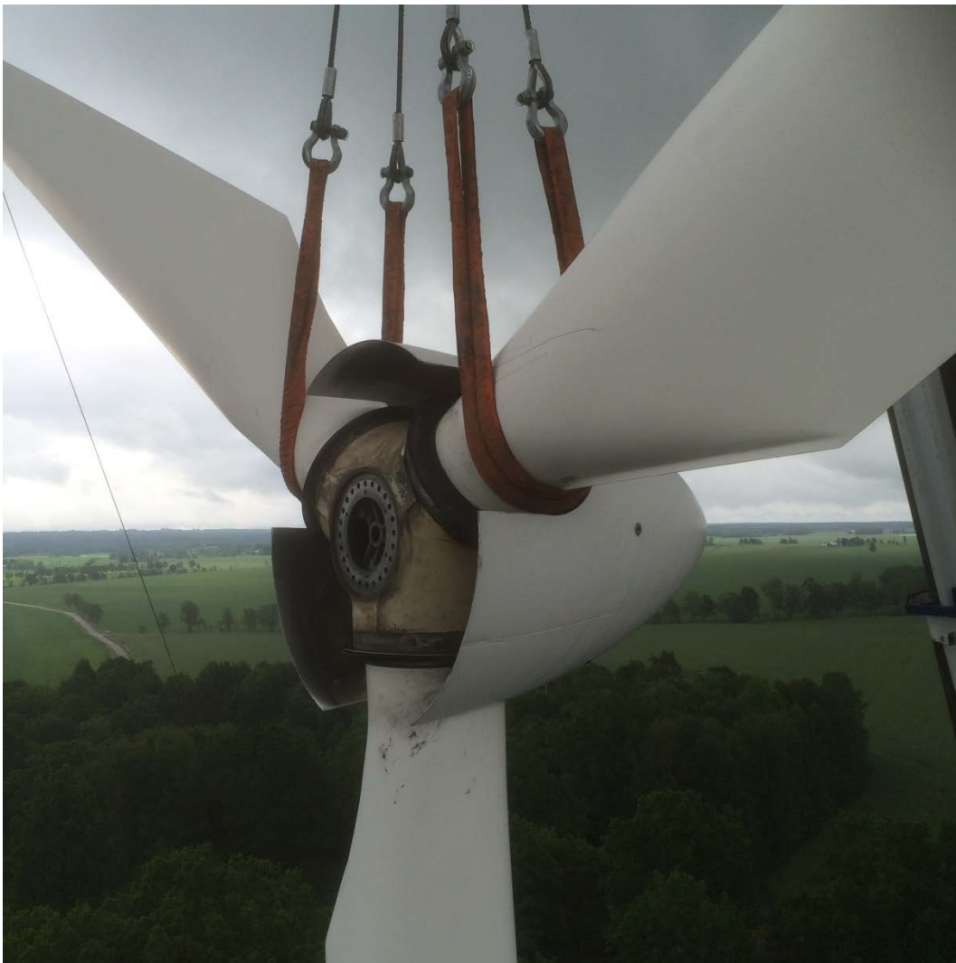
Nedmontering av vindkraftverk. Foto: Mats Flodman
